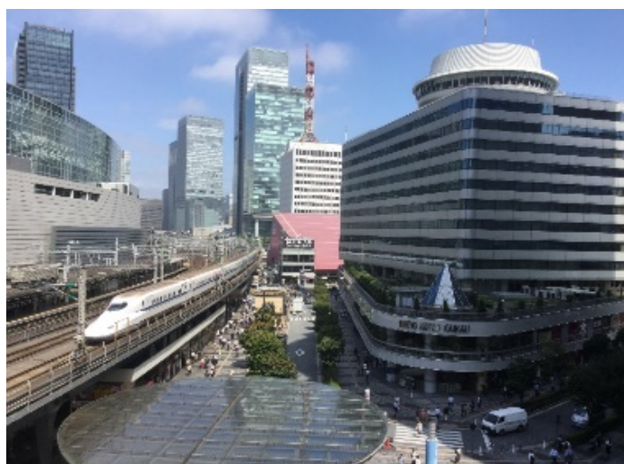
東京交通会館 全景
